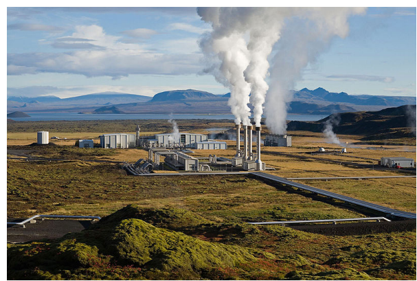
Centrale géothermique de Nesjavellir en Islande
